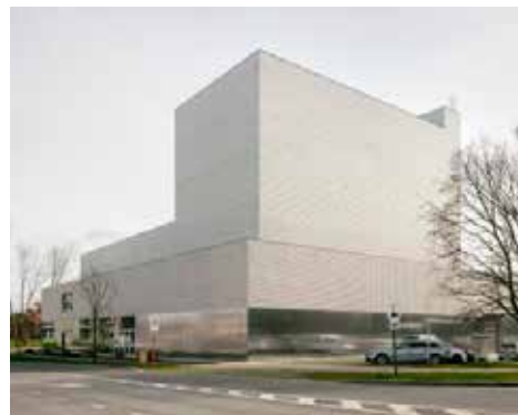
Leietheater, Deinze Nieuwbouw
